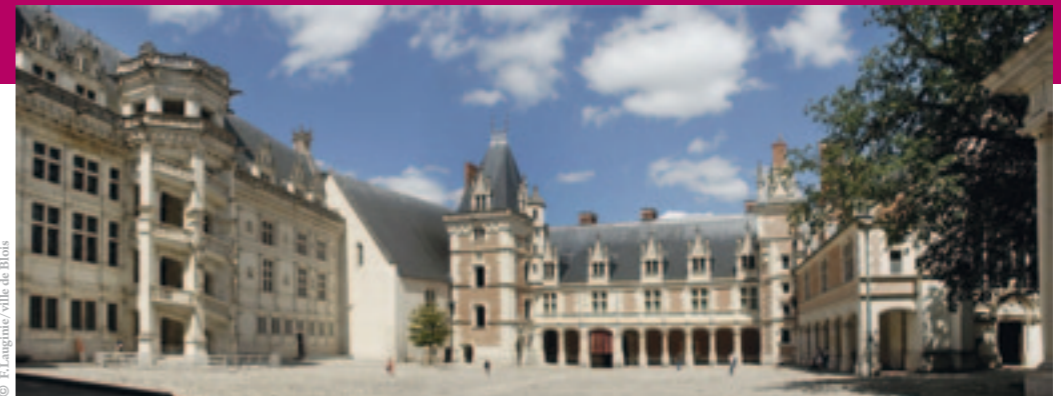
La cour intérieur
